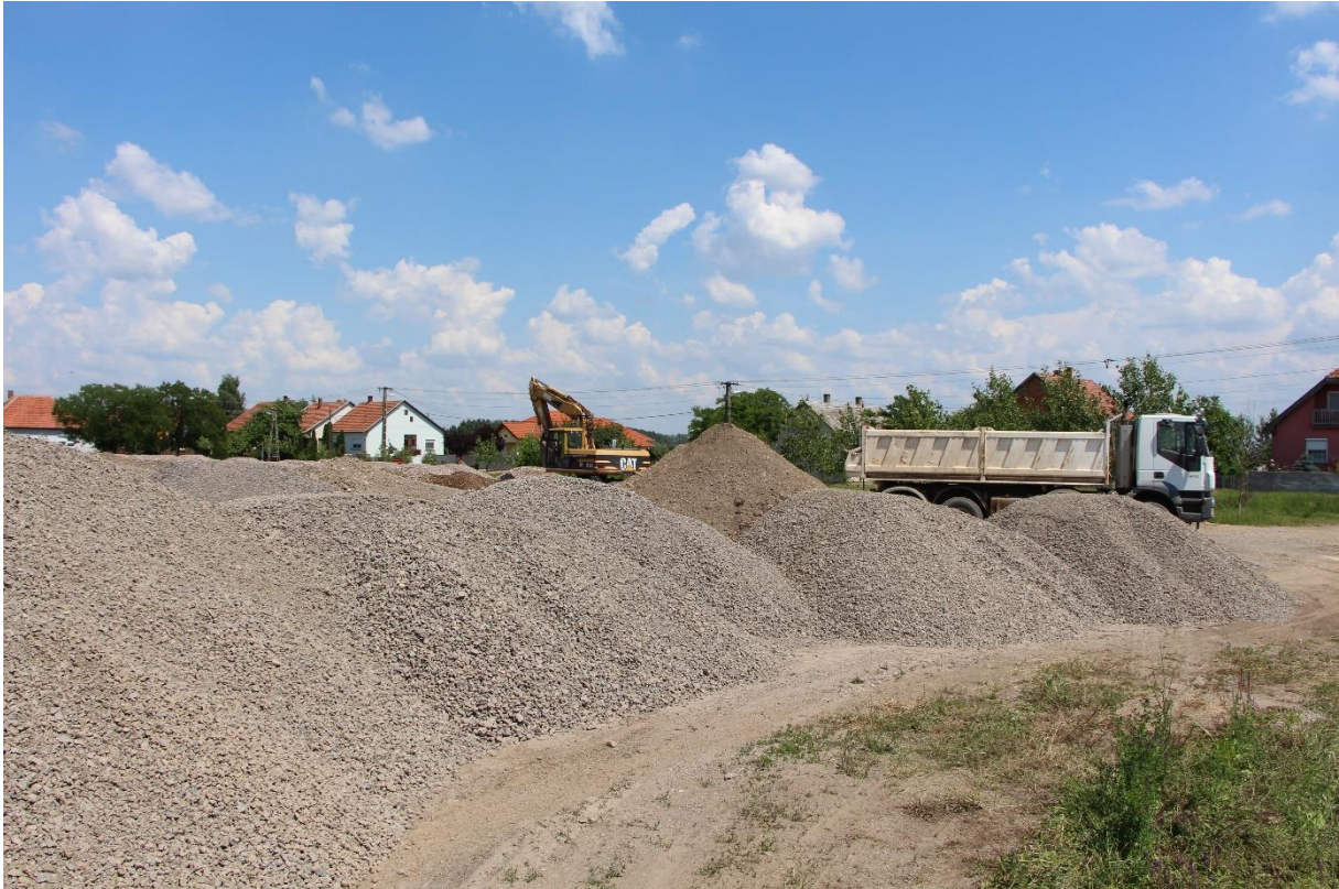
3. ábra Zúzottkő depónia az építési területen
